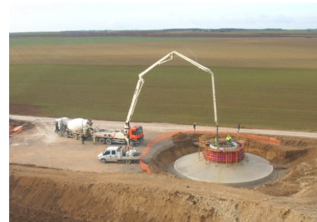
Photo 5 : Emprise des fondations
