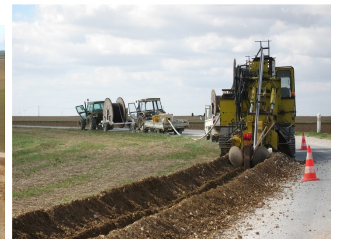
Photo 6 : photographie du raccordement enterré
